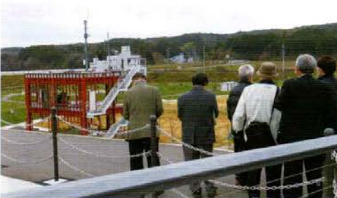
▲南三陸町の旧防災対策庁舎
